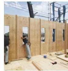
耐震壁パネル 壁面全体で地震に耐える、高倍率壁パネル！
